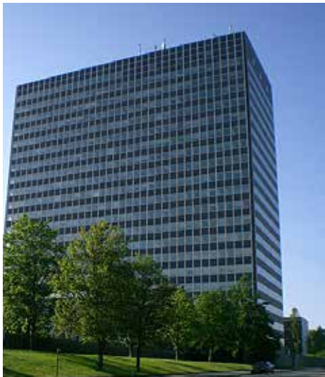
Das Siemens-Hochhaus wird saniert und bleibt Bürogebäude. Foto: G. Fetzer-Wenngatz
